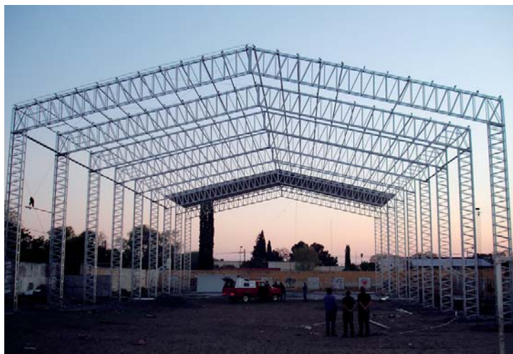
Bau einer grossen Halle als Mehrzweckraum
