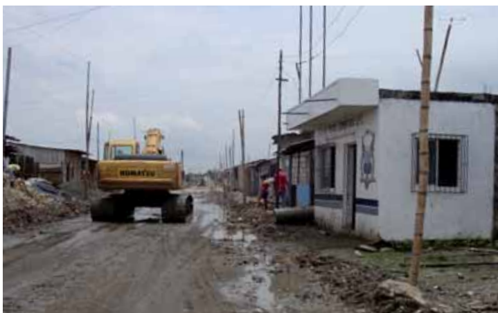
Mit der Aufschüttung ist bereits begonnen worden.
