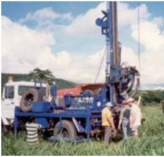
Am Anfang jedes Brunnens wird gebohrt
