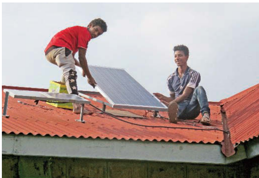
Installation eines Solarpanels auf einem Wohnhaus. (Bilder: Salesianer Don Boscós)
